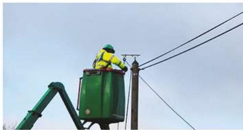
Des travaux d'implantation de poteaux ont été conduits par l'opérateur Orange. Ils ont pour but de fournir la fibre aux habitants et de pallier à la disparition annoncée des réseaux dits "Cuivres".
