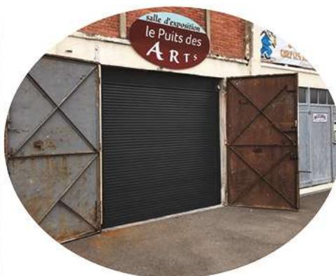
La salle d'exposition du Puits des Arts a été équipée de volets roulants électriques intérieurs. Ceux-ci permettront de laisser les grandes portes métalliques d'origine du bâtiment ouvertes pendant toute la durée des expositions. En effet, de par leur âge et leur taille celles-ci s'avèrent peu pratiques à ouvrir et fermer quotidiennement. L'installation de ces volets roulants en intérieur permet de ne pas modifier l'aspect extérieur de l'un des bâtiments emblématiques de notre village.
